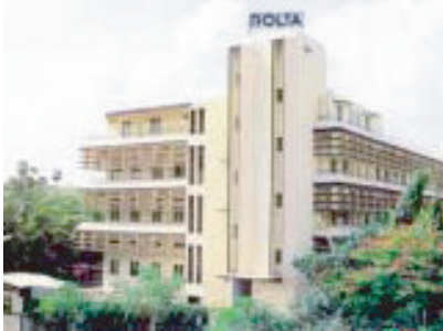
Het Conversiecentrum in Bombay
