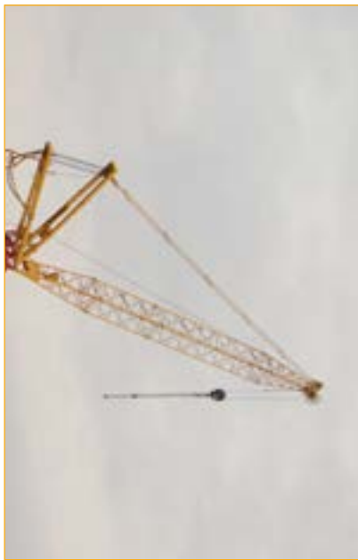
Kraan voor de bouw van Carré
